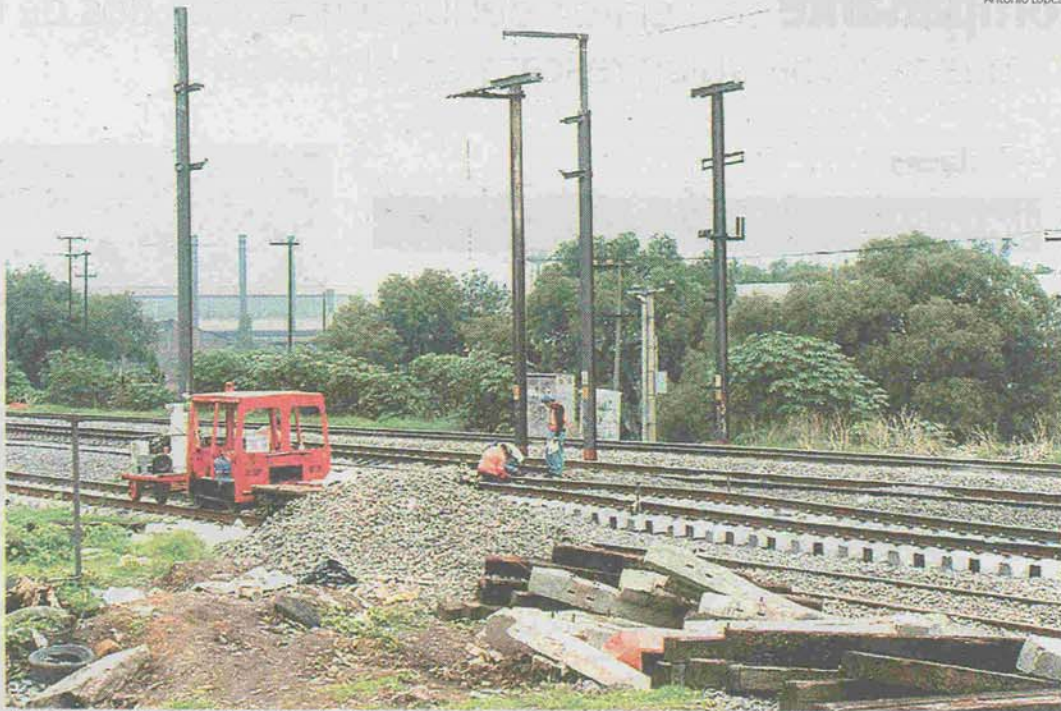
Está a 75 por ciento el avance de la obra
